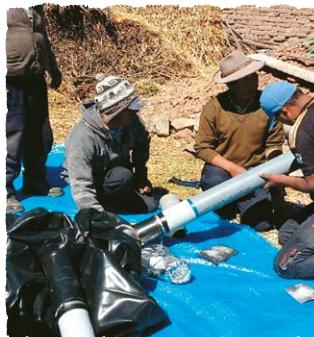
De la misma forma, en el otro extremo del biodigestor, se colocarán los dos tubos de proyección (tubo de salida de biol 1.30m longitud y tubo de salida de biosol 1.50m longitud), para la unión se debe proceder al igual que el anterior, y también sellar la tapa del tubo de salida de biol, mientras que el tubo de salida de biosol debe ser sellada con llave de paso de 4" diámetro.
