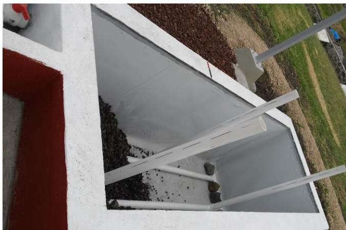
g) Instalación de la red de tubería de recolección.
