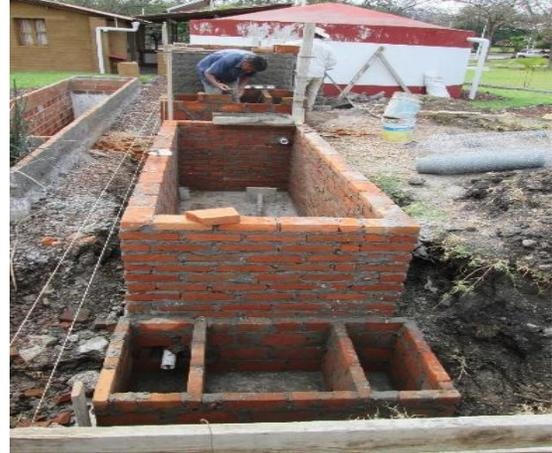
b) Instalación de las celdas y cajas de muestreo.
