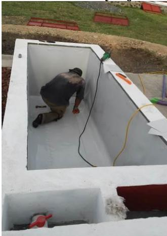
e) Impermeabilización de cada celda con geomembrana.
