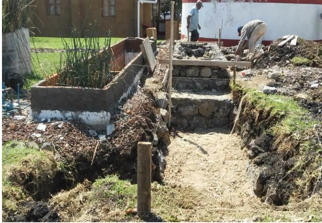
a) Instalación de la plataforma de concreto para el humedal
