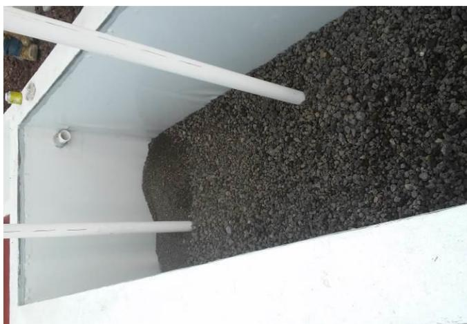
i) Relleno de la celda con material granular. Segunda capa y tercer capa.
