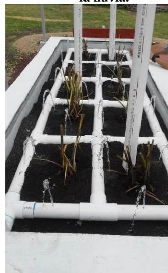
L) instalación de red de tubería de distribución del agua.
