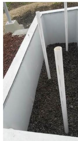
h) Relleno de las celdas con material de granular. Primera capa.
