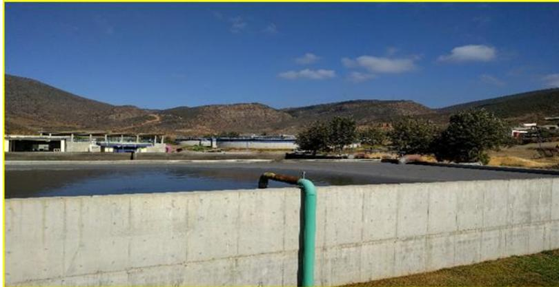
Figura 17. Tanque de almacenamiento de lodos (Espesadores, mal llamados digestores).
