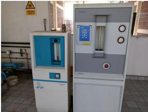
Figura 15. Cloradores, funcionando al mínimo.
