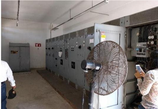
Figura 32. Centro de Control de motores.
