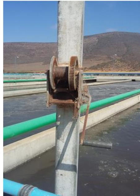
Figura 26. Oxidación en diversas estructuras.
