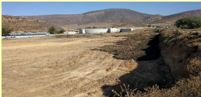
Figura 18. Mezcla de lodos con material del terreno y disposición in situ.
