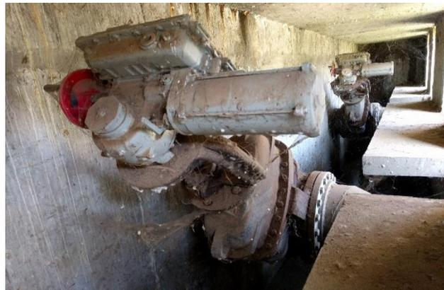
Figura 54. Válvulas fuera de operación.
