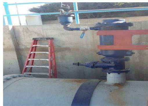
Figura 38. Válvula de aire fuera de servicio.
