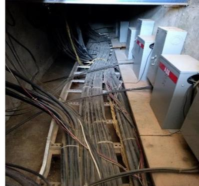
Figura 33. Cableado expuesto.
