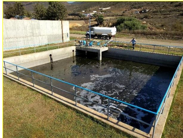
Figura 48. Tanque de sobrenadantes y agua de lavado.
