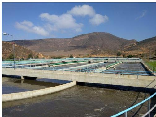
Figura 42. Zanjás de oxidación.
