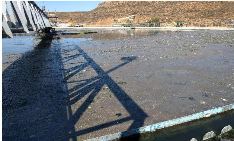
Figura 14. Sedimentador colmatado fuera de servicio.
