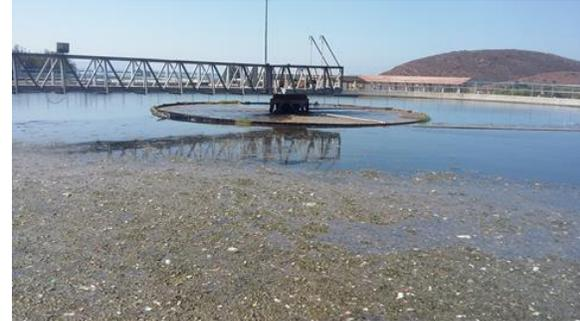
Figura 45. Sedimentador colmatado, rastras fuera de operación.
