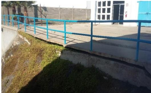
Figura 35. Deslizamiento del terreno.
