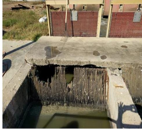
Figura 24. Rejillas en mal estado.
