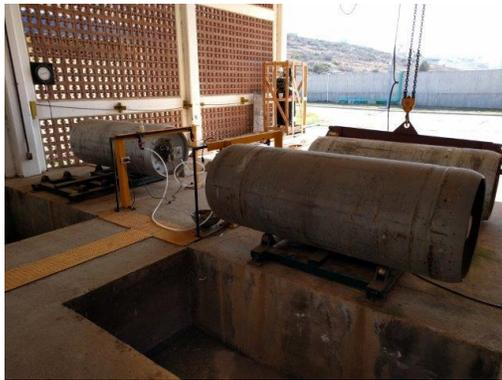
Figura 55. Tanques gas cloro de 907 kg.
