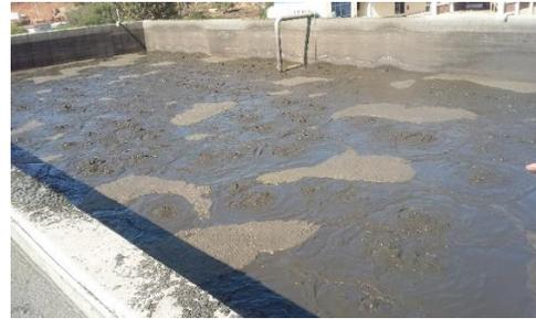
Figura 47. “Espesador” con aireación.
