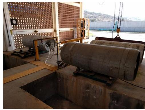
Figura 16. Cilindros de cloro, faltan los de reserva.
