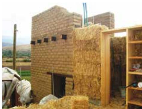
**Fig. 2.64** Construcción con paja, madera y adobe.
