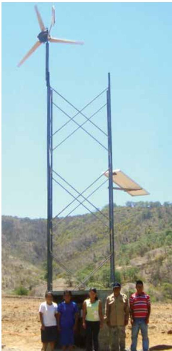
**Fig. 2.24** Sistema autónomo híbrido (eólico-solar).
