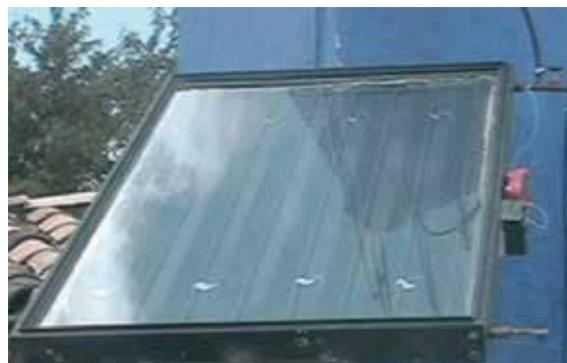
**Fig. 2.36** Calentador solar de colectores planos.
