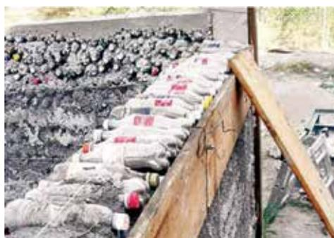
**Fig. 2.65** Construcción con PET y paja.
