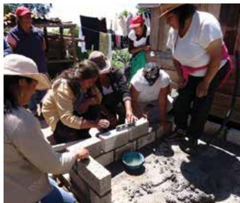
**Fig. 2.70** Construcción de un sanitario ecológico seco.
