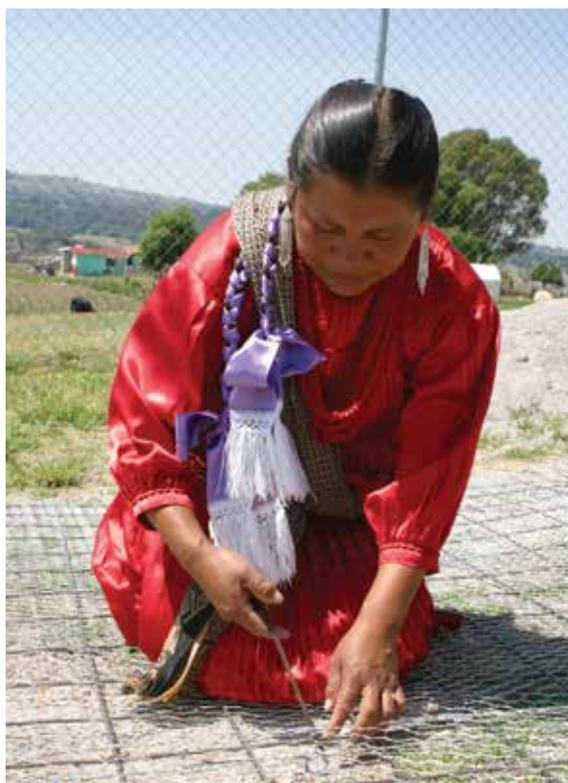
Fig. 2.67 Trabajo en el tejido de la malla para una cisterna de ferrocemento.
