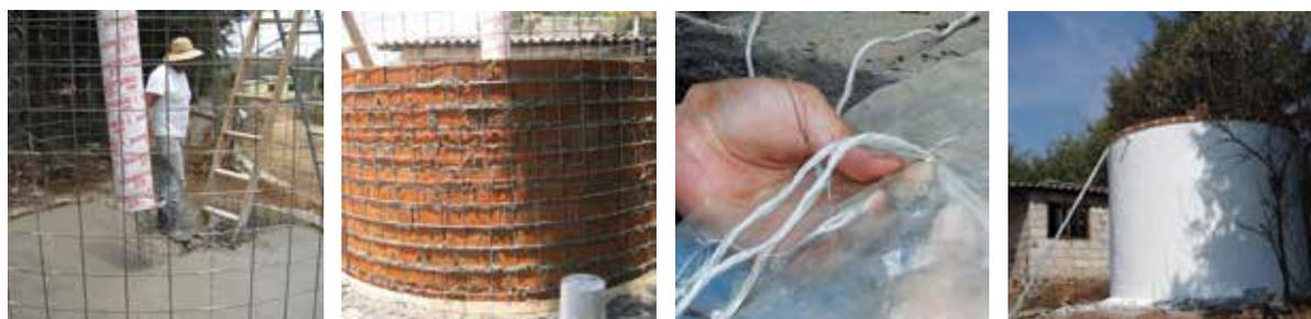
**Fig. 2.40** Ejemplo de construcción de cisterna de ferrocemento.
