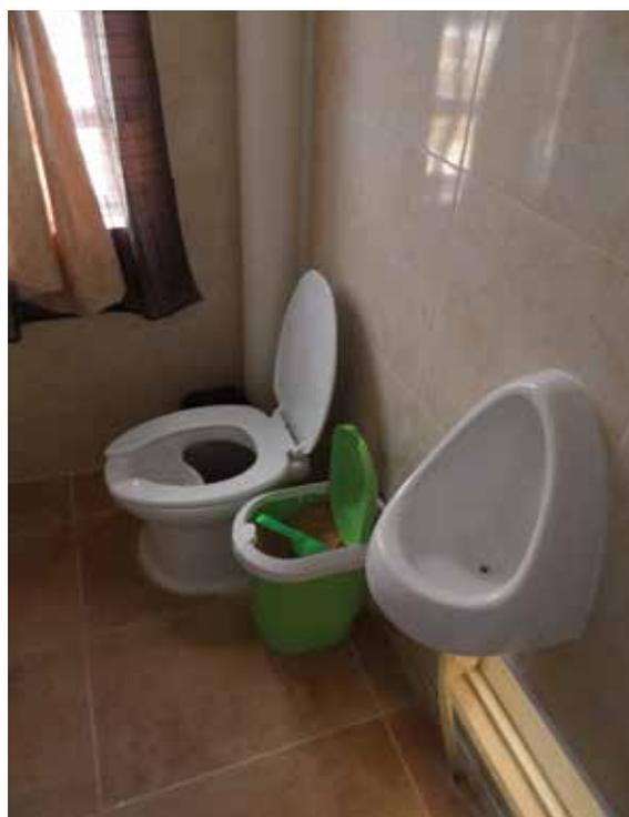
**Fig. 2.53** Mingitorio seco junto a sanitario ecológico seco.
