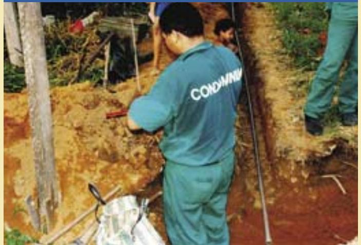
diámetro de estos ramales fue similar a los usados en los edificios verticales, cumpliendo con las especificaciones en cada caso. Una revisión detallada de parte de la red indicó que aproximadamente 55% de los ramales utilizó tuberías de 32 milímetros, mientras que el restante 45% lo hizo con tuberías de 25 milímetros.
