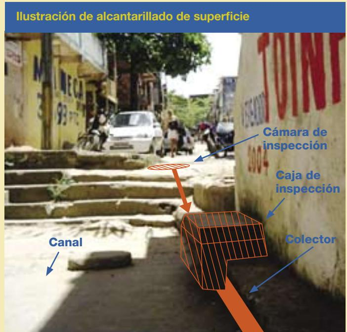
colindantes. El alcantarillado superficial estaba protegido con un revestimiento de concreto, que contaba con la ventaja agregada de ofrecer una acera que facilitaba el movimiento de los residentes locales (fotografías del alcantarillado de superficie). Esta propuesta probó ser mucho más económica que cavar la colectora en el terreno rocoso, y desde entonces se usa ampliamente en Salvador y en otras ciudades brasileñas de suelo rocoso.
