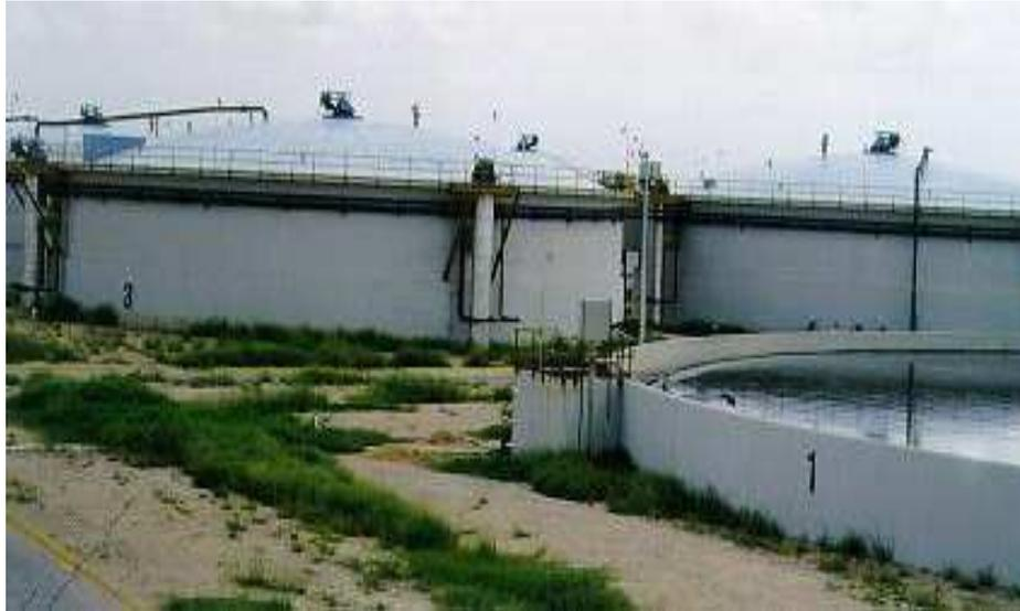
Un digester típico de alta tasa reducirá el contenido de sólidos volátiles del lodo entre 40 y 65 %.
