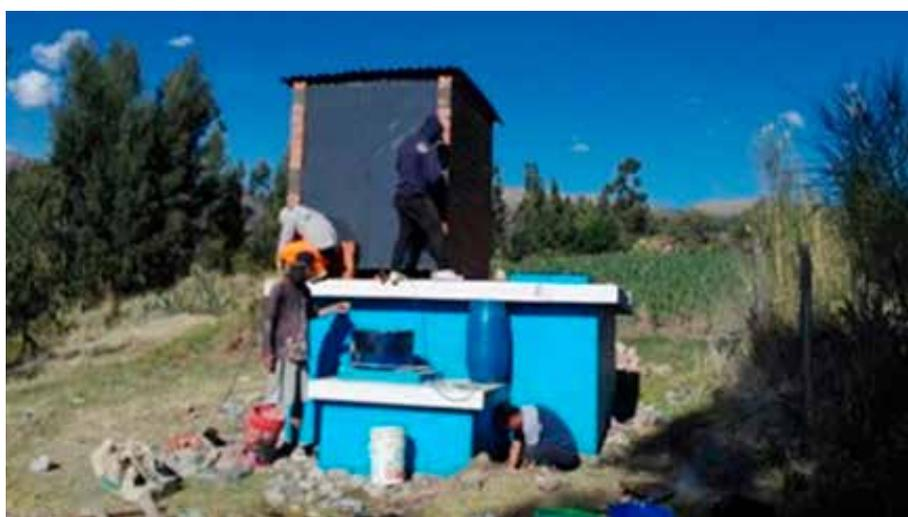
Instalación de techo ligero (calamina) y puerta metálica de doble hoja.
