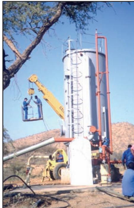
Construcción de un sistema de carbono activado, cercano a un pozo de inyección en Windhoek, Namibia
