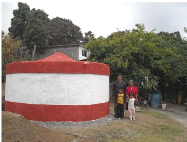
Cisterna de 20 m 3 .
