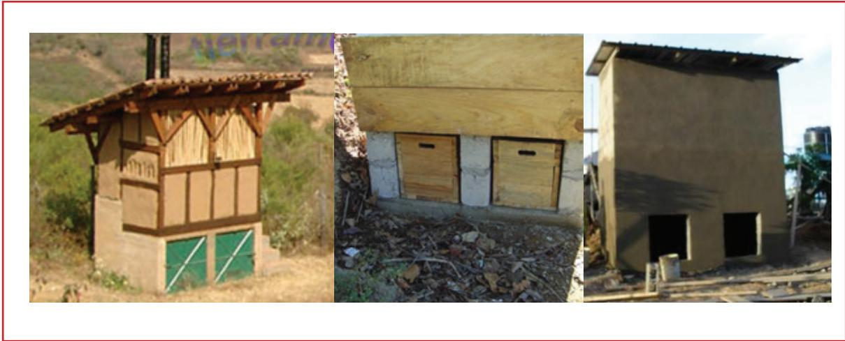
produce menor cantidad de gases olientes y algo de humedad. Unas pequeñas aberturas en los costados de los muros son suficientes para que esos gases escapen.
