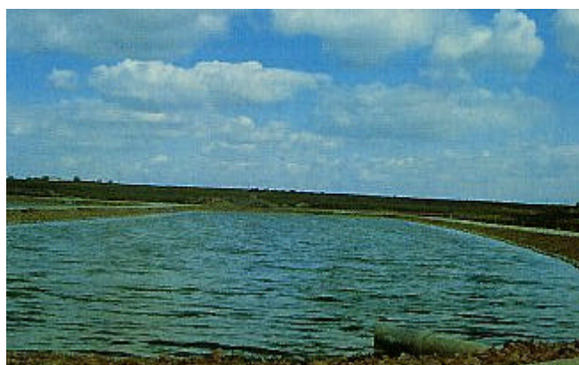
Foto 11.4. Efecto del viento en la reaireación y formación de olas en una laguna facultativa (cortesía de TRAGSA).
