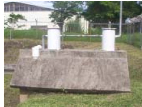
Biodigestor para lodos en planta para el tratamiento de aguas residuales en Urb. Bosques de Santa Ana, San José, Costa Rica. Fotografía tomada por unidad Aguas residuales del AyA, Costa Rica
