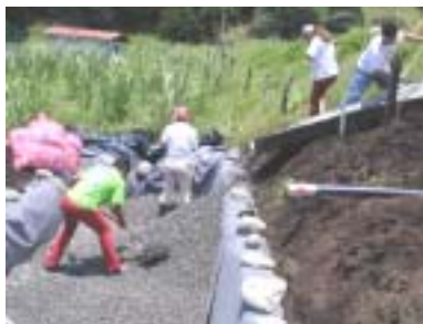
Colocación de materiales a utilizar como filtro
