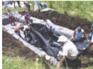
Colocación de materiales impermeabilizantes en fondo de
