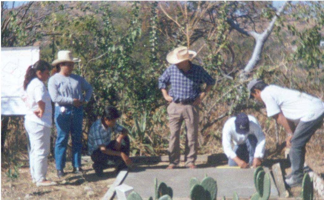
Luego se construyen las cámaras, hasta 80 centímetros de altura, bien enjarradas por dentro y por fuera. Se dejan compuertas de vaciado de 60 x 40 cm.
