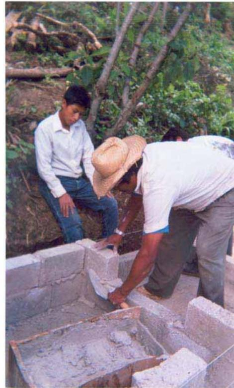
Se prepara la cimbra con las varillas de 3/8". Cuatro varillas cortas y cuatro largas. Sobre la cimbra se acomodan los moldes para dejar listos los huecos donde se colocará la taza. Y se echa el colado de 7 centímetros de espesor.
