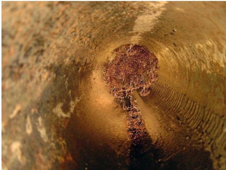
Figura 2.8. Obstrucción por raíces de un sistema de alcantarillado
