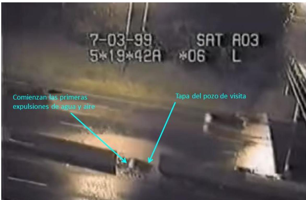
Figura 4.18. Primeros indicios de la formación de un Géiser
