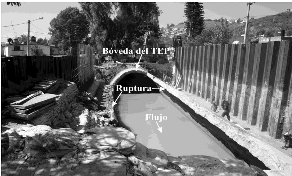
Figura 4.1. Ruptura del Túnel Emisor Poniente
