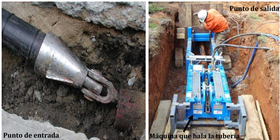
Figura 3.1. Puntos de inicio y de salida de la tubería sustituida sin zanja
