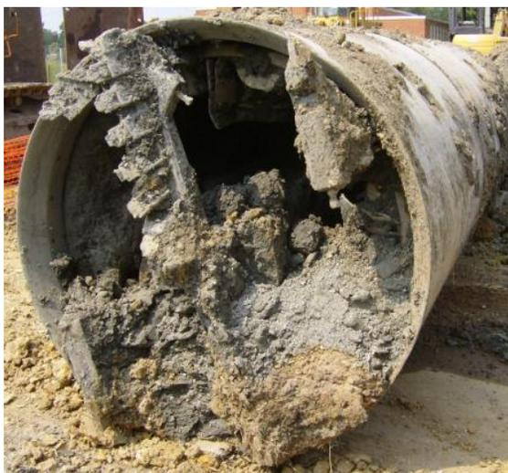
**Figura 2.18. Arenas y piedras en el alcantarillado**
