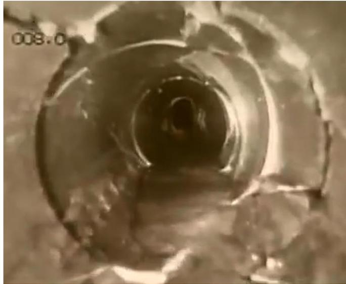
**Figura 3.11. Inspección con cámara de una tubería de drenaje con fracturas**
