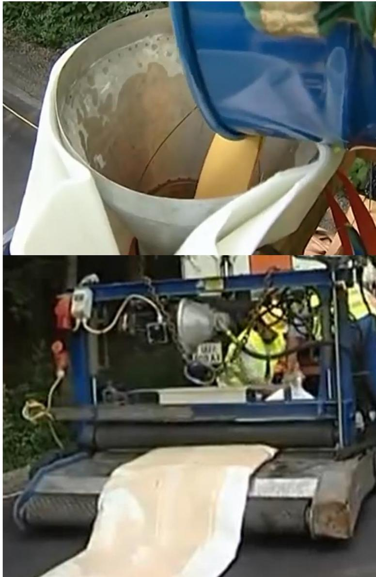
**Figura 3.14. Impregnación de la resina epóxica**
