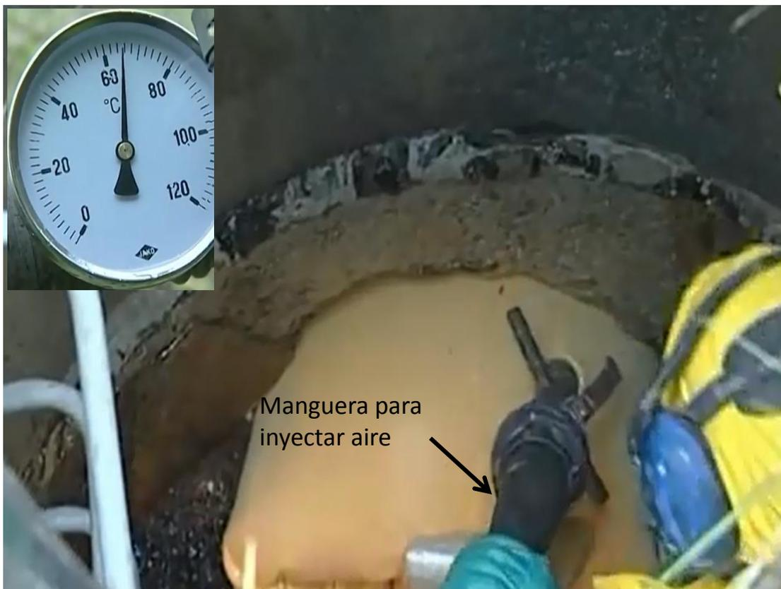
**Figura 3.16. Inyección de vapor**
