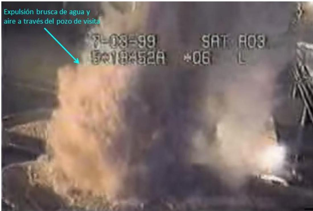
Figura 4.19. Formación del Géiser.
