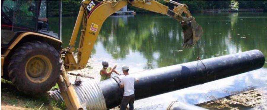
**Figura 3.8. Recubrimiento interior por empuje**
