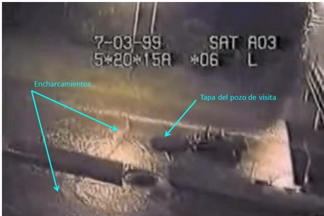
Figura 4.20. Encharcamientos causados por el Géiser.
