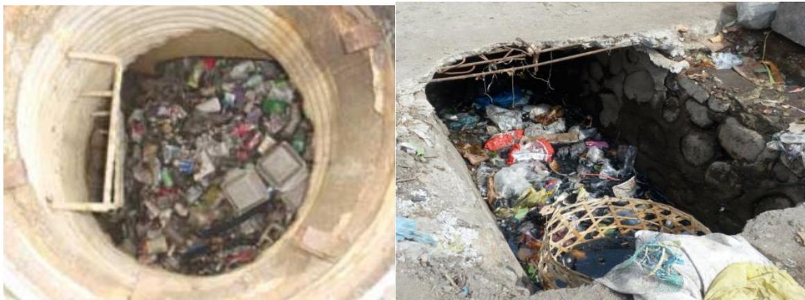
**Figura 2.17. Basura en el alcantarillado**
