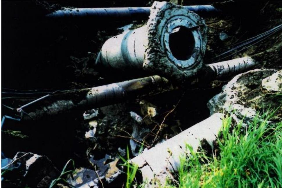
Figura 4.16. Ruptura de la Infraestructura del drenaje de la Ciudad de Edmonton, Canadá
