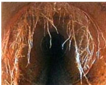
**Figura 2.9. Raíces que penetraron por aberturas microscópicas**
