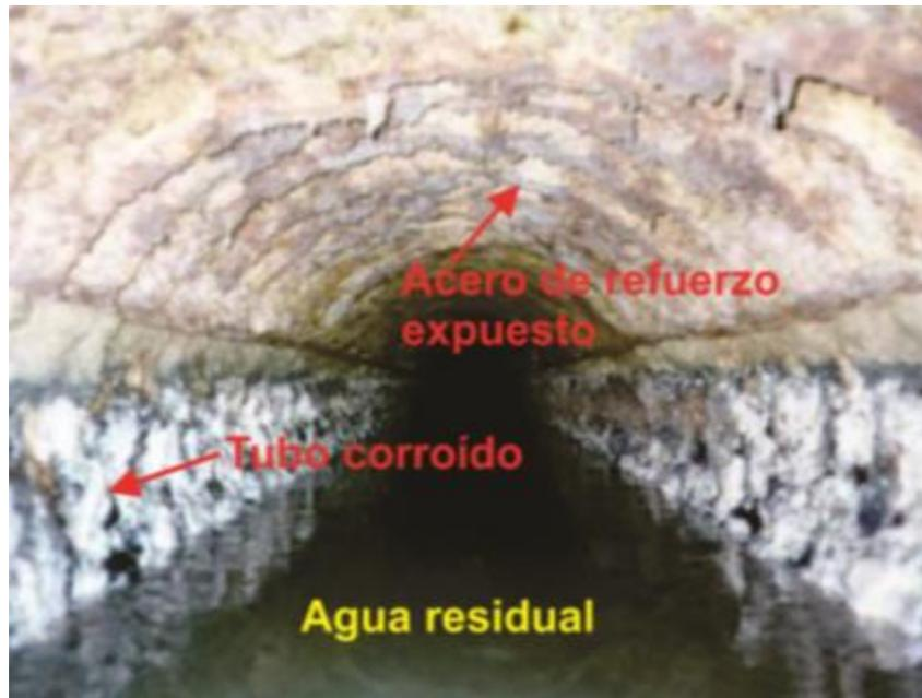
Figura 2.5. Tubería de concreto corroída con el acero de refuerzo expuesto (Basurto et al. 2012)
