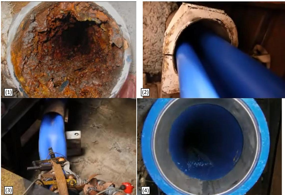
Figura 3.10. Proceso de revestimiento con tubo flexible
