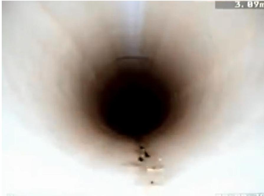
**Figura 3.17. Tubería renovada**
