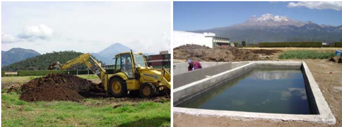
Construcción y acondicionamiento de estanques en la UAP AMECAMECA
