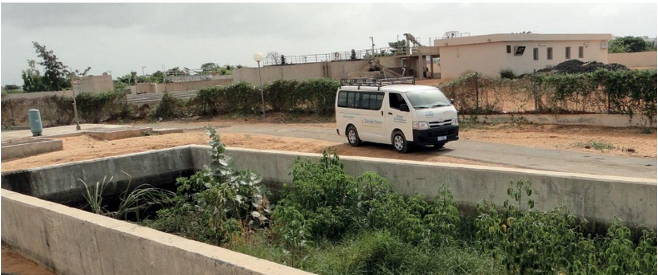
**Figura 6.5** Ejemplo de operación y mantenimiento inadecuados de un tanque de sedimentación y espesamiento en África Occidental. La nata no se había sacado durante tanto tiempo que ciertas plantas ya crecían sobre ella. La acumulación de un exceso de lodos o nata impide la debida operación de este tipo de tanque que sirve para decantar sólidos y líquidos (foto: SANDEC).
