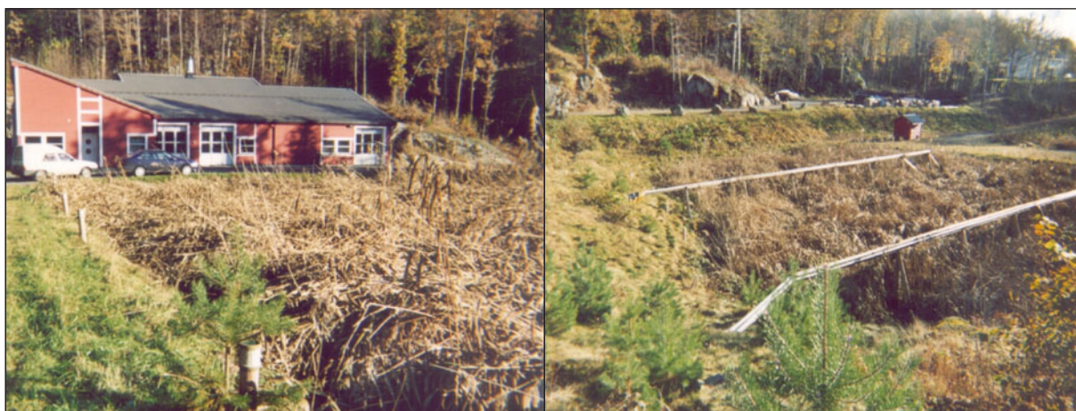
Figur 3-41. Øvre bassengområde til venstre og nedre til høyre. Merk fordelingsrørene i nedre basseng.
